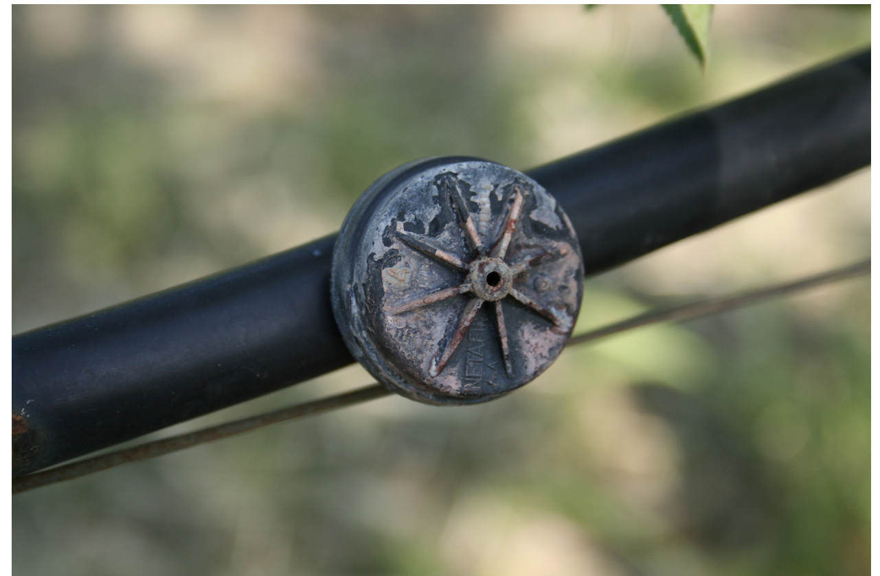
Figura 1. Degoter obstruït a causa d'un mal manteniment de la instal·lació (Foto: ECA Tàrrrega).
