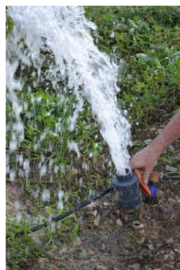
Foto 3: Obertura de vàlvula de neteja del sector
